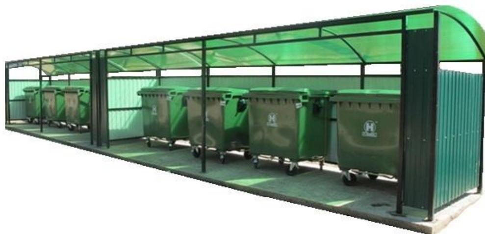
5.7. Уклон покрытия площадки устанавливается составляющим 5 - 10% в сторону проезжей части, чтобы не допускать застаивания воды и скатывания контейнера.
