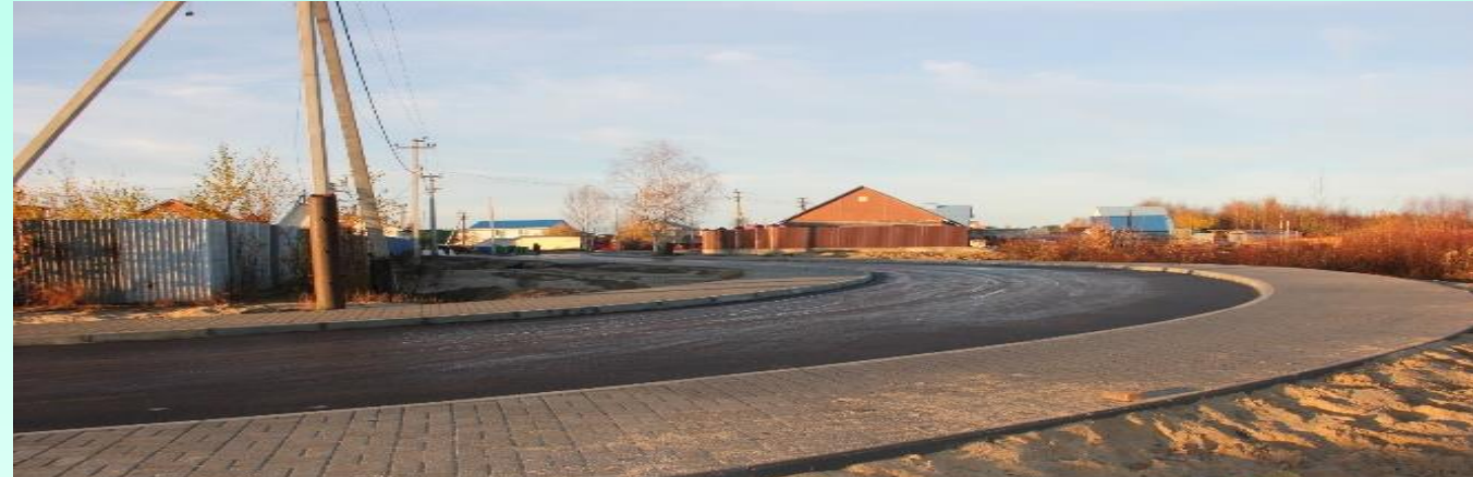
Реконструкция автодороги в 6 мкр. города Белоярский
