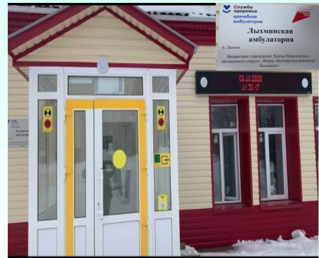
Реконструкция врачебной амбулатории в с.п. Лыхма
