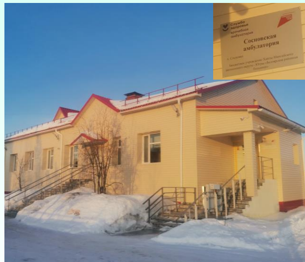
Реконструкция врачебной амбулатории в с.п. Сосновка
