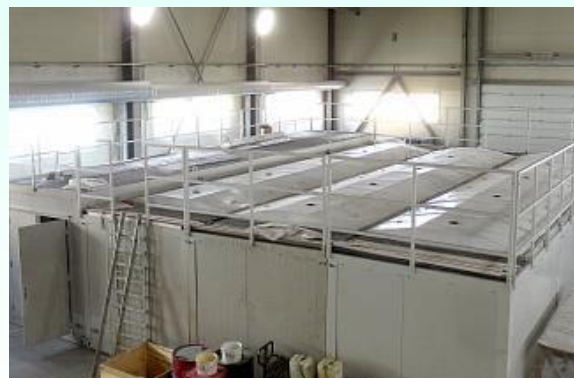
Строительство КОС в с. Казым Белоярского района
